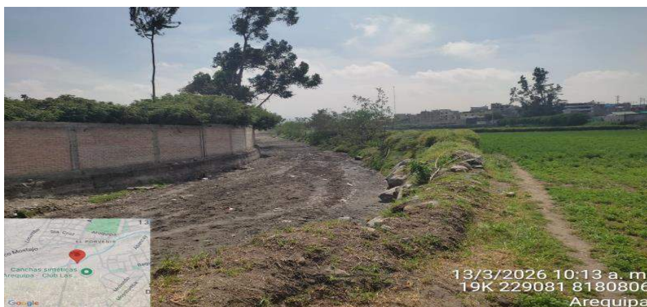
IMAGEN 02: SE OBSERVA LA COLMATACION DE LA QUEBRADA S/N, PRESENTA UN MURO DE CONCRETO DE APROXIMANADAMENTE 1.10 DE ALTURA EN LA MARGEN DERECHA ASI COMO LA MARGEN IZQUIERDA QUE NO PRESENTA MURO SE REQUIERE DE LA CONTRUCCION DEL MISMO
