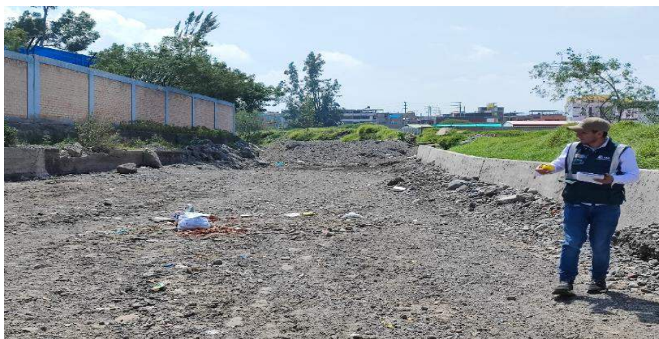
IMAGEN 03: SE OBSERVA EL MURO DE CONCRETO ARMADO EN AMBAS MARGENES DE 1.10 ,m DE ALTURA EN EL TRAMO FINAL ANTE UNA AVENIDA, EL AGUA SE DESBORDARIA INUNDANDO AGUAS ABAJO SE REQUIERE DE DEMOLICION Y CONSTRUCCION
